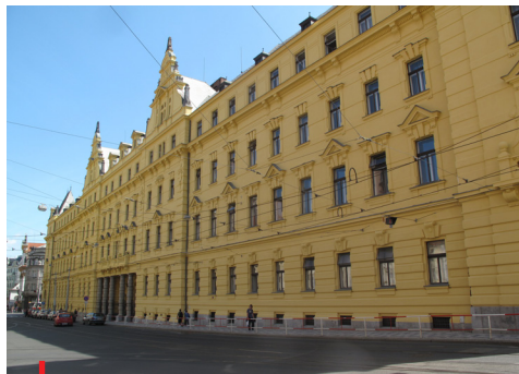
Budova Městského soudu v Praze
